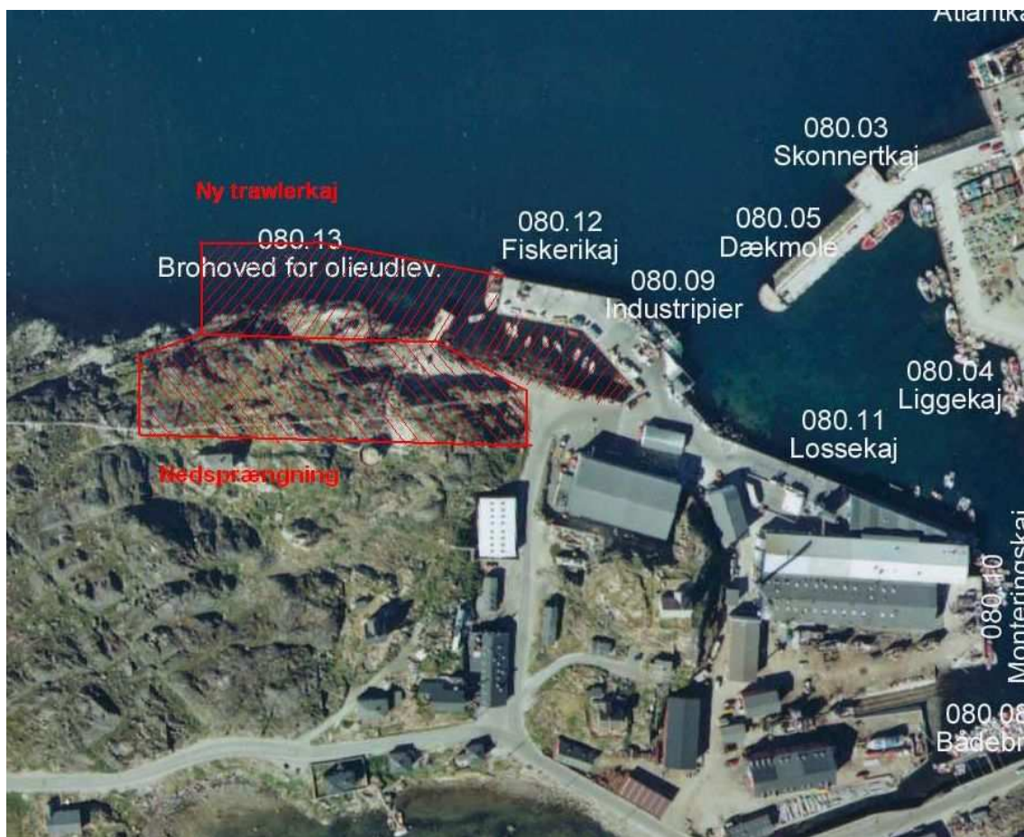
Figur 3: Udbygning af fiskerikaj og nedsprængning af fjeldet i Sisimiut
