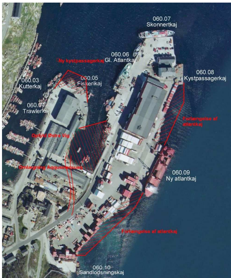
Figur 1: Containerarealet i Nuuk
