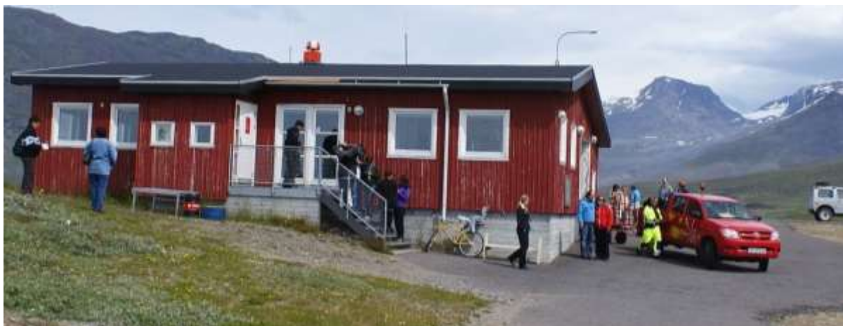
Figur 24: Terminalbygning ved Narsaq helikopterflyveplads (kilde: Wikipedia)
