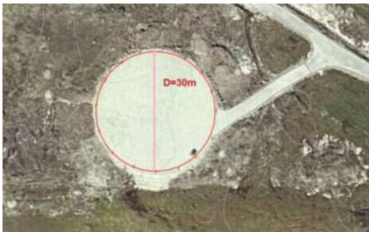
Figur 46: Akunnaaq Helikopterflyveplads (kilde: Mittarfeqarfiit)
