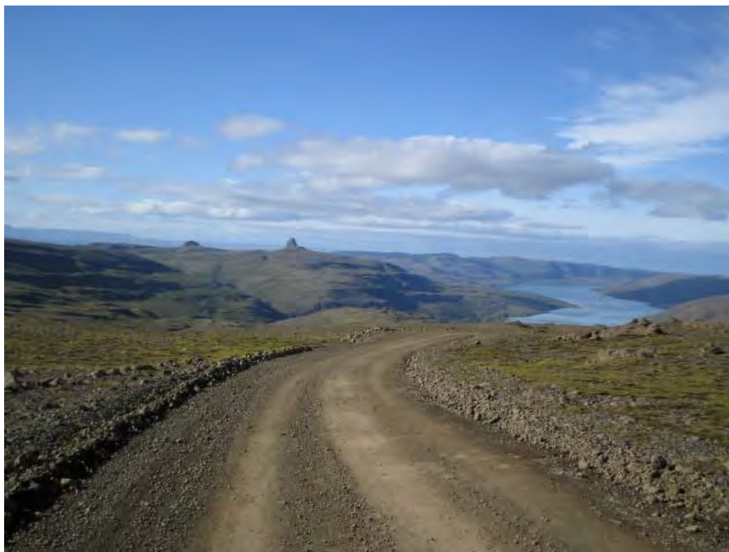
Figur 1.14. Eksempel på en grusvej, som vejen mellem Kangerlussuaq og Kangerluarsuk Tulleq forventes at ville se ud på de strækninger, hvor den ikke kan anlægges på fjeld.
