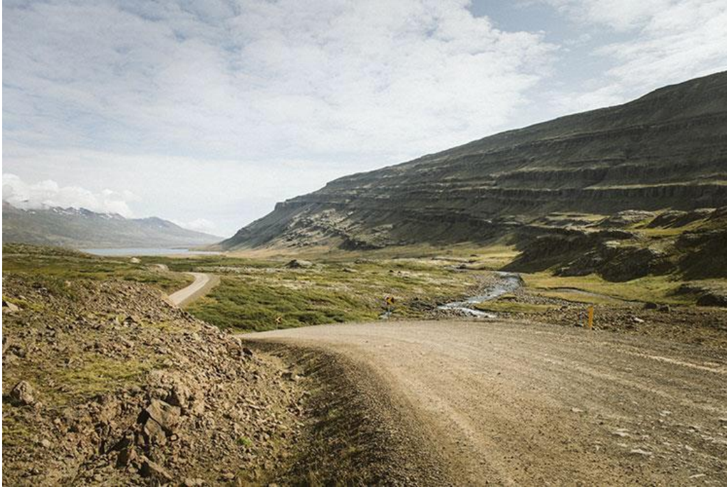
Takussutissiaq 4-5. Aqqummut ujaraaraasumut assersuut, suliniut naammassippat isikkussaatur naatsorsuutigisaaq. Aqqut takutinneqartoq aqqusinniornermi assaanertaliuvoq, aqqutissap ilaannaani kisimi atorneqartussamik.
